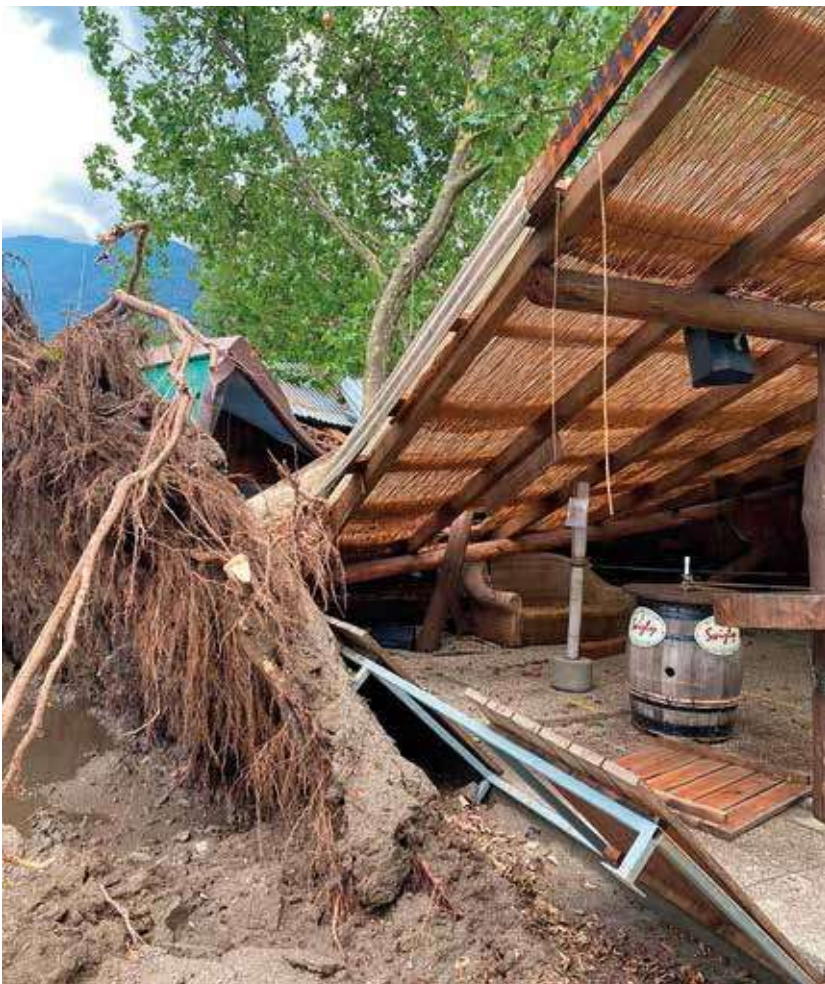
Ingenti danni al bar del bagno pubblico, fortunatamente senza feriti.
