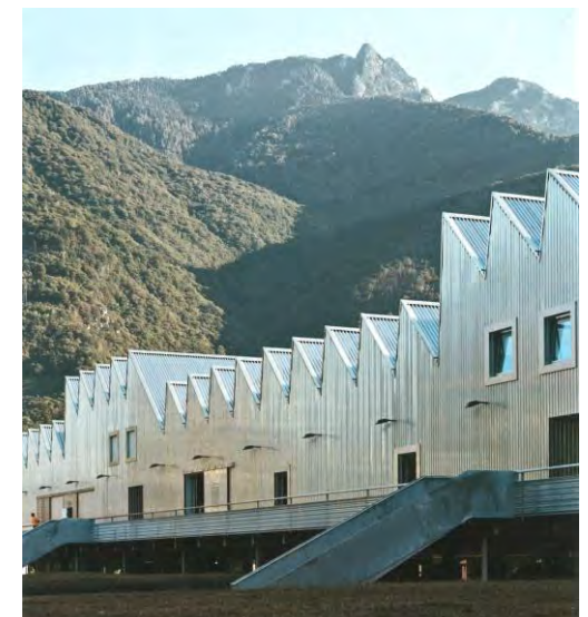
Durisch+Nolli Architetti Centro di formazione SSIC, Gordola
