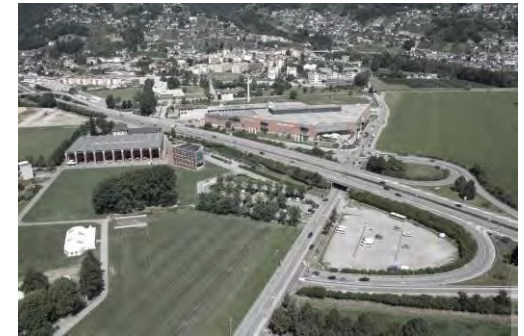
CST e svincolo stradale A13
