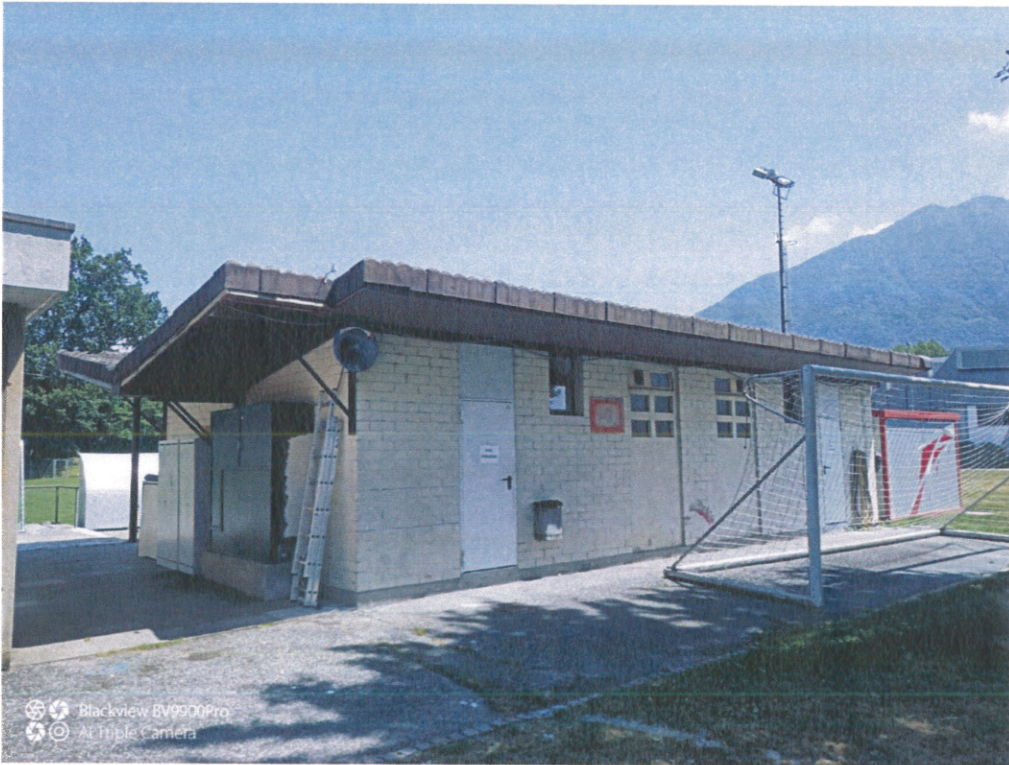
Foto edificio da demolire.
