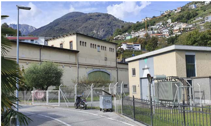
La "vecchia" centrale oggi, con a destra lo stabile della nuova centralina.
